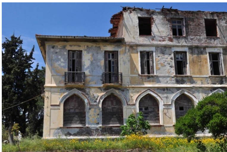
Εικόνα 5.1: Φωτογραφική λήψη τμήματος του ξενοδοχείου. Η πρακτική εφαρμογή αφορά στο ισόγειο τμήμα της κεντρικής όψης.
